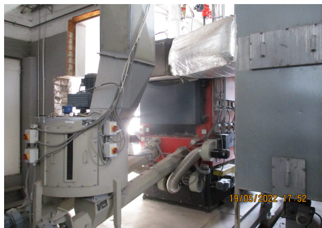
Tabivere katlamaja: II plokk ja selle hakkepuidukatelseadmed
