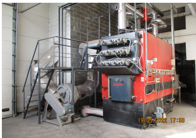
Tabivere katlamaja: II plokk ja selle hakkepuidukatelseadmed
