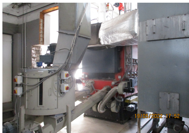
Tabivere katlamaja: II plokk ja selle hakkepuidukatelseadmed
