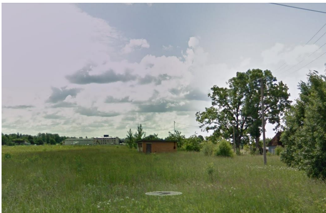
Joonis 8-1 Tabivere Voldi pumbajaama pumpla välisvaade (Google Mapsi kuvatõmmis)
