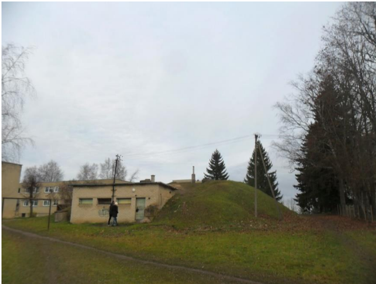
Joonis 5-9 Tabivere VTJ ja II-astme pumpla välisvaade (reservuaar on muldes)
