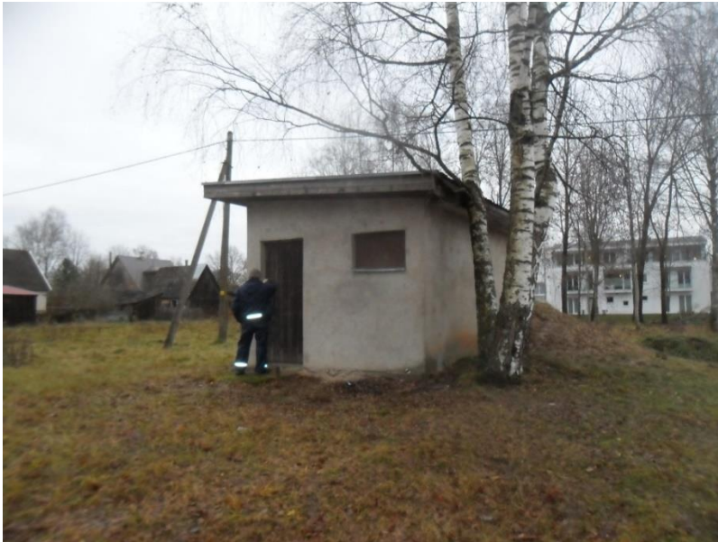
Joonis 5-3 Kõrveküla-Sopaku puurkaevpumpla hoone välisvaade
