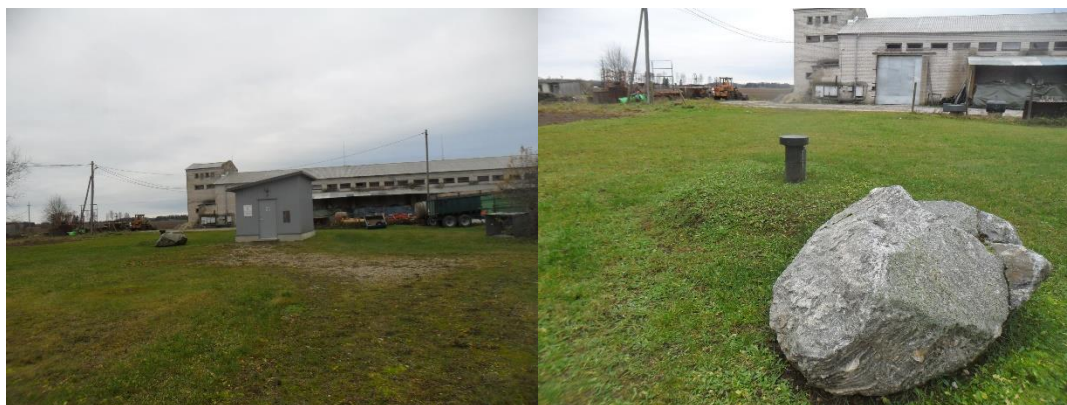
Joonis 5-21 Sojamaa puurkaevpumpla välisvaade ja puurkaevu päis
