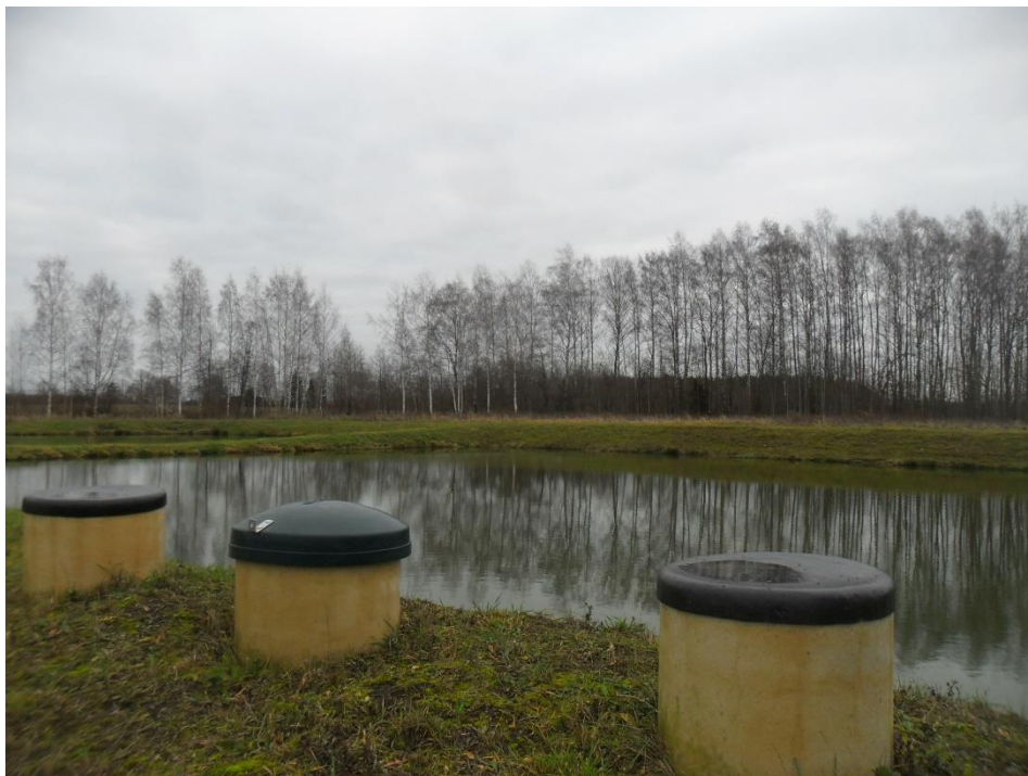
Joonis 6-15 Tammistu biopuhasti septiku maapealsed luugid ja biotiigid
