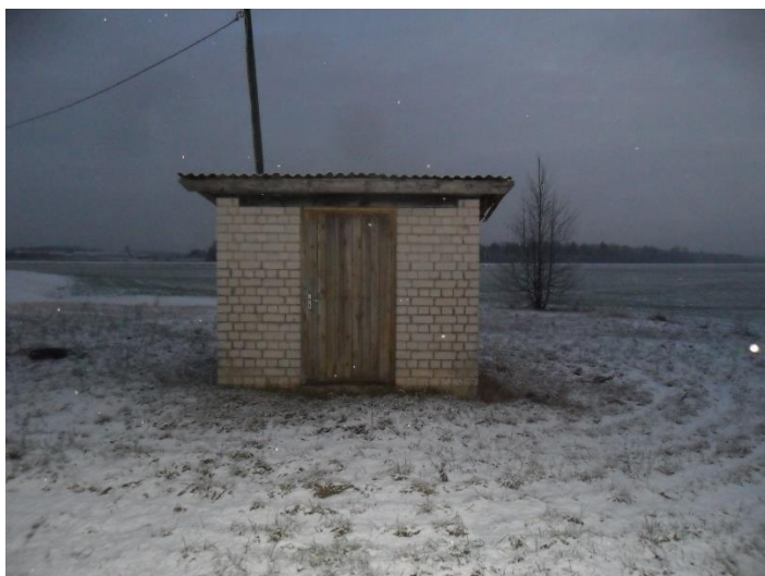
Joonis 5-17 Laeva Mällomäe puurkaevpumpla välisvaade
