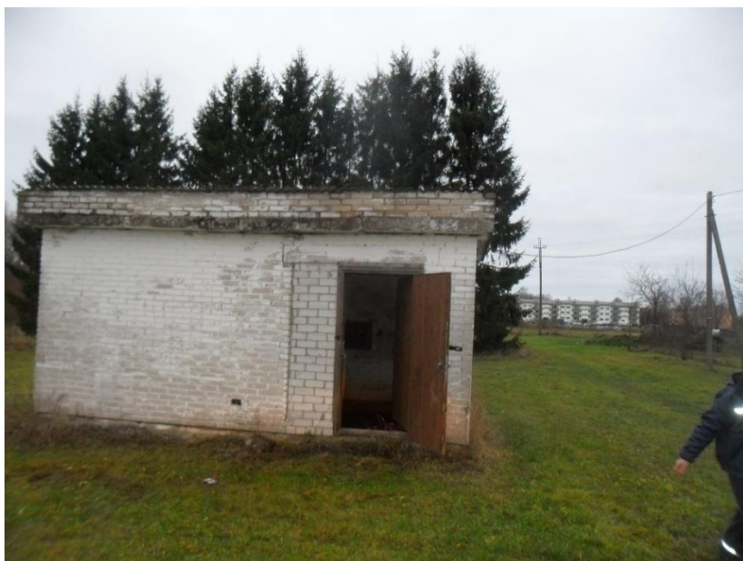
Joonis 5-1 Kõrveküla puurkaevpumpla nr 7253 välisvaade
