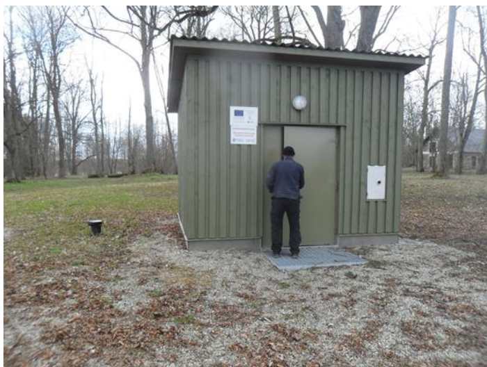
Joonis 5-7 Pargi puurkaevpumpla välisvaade
