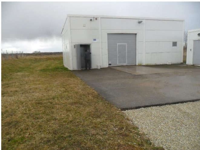
Joonis 6-3 Tabivere reoveepuhasti välisilme, kõik tehnoseadmed paiknevad hoones
