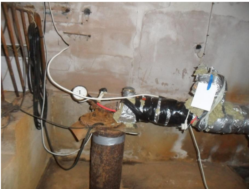
Joonis 5-4 Sopaku puurkaevpumpla sisevaade. Puurkaevu päis ja soojustatud torustik
