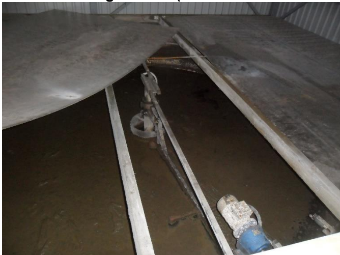
Joonis 6-5 Aerotank (nagu kõik teisedki protsessid, toimub bioloogiline puhastus siseruumides)
