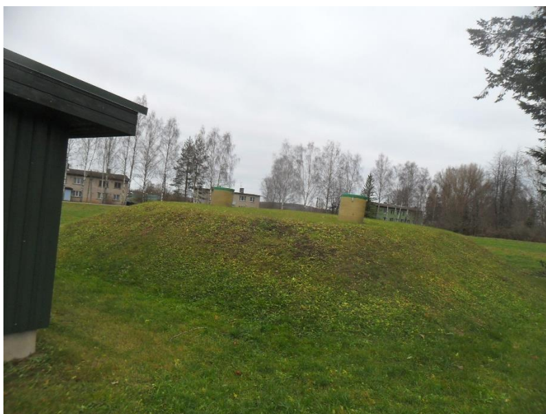
Joonis 5-15 Vasula puurkaevust täidetavad tuletõrjeveemahutid 2x40 m 3
