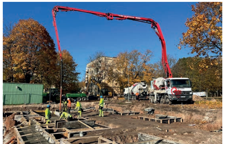
Katlamaja-büroohoone ehitustöödega alustati oktoobris. Foto: Tartu Valla Haldus
