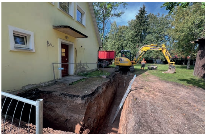
Septembris teostatud torustiku ehitustöödega liideti Lähte küttevõrguga noortekeskus ning kaugküttevõrk Lähel laienes. Foto: Tartu Valla Haldus
