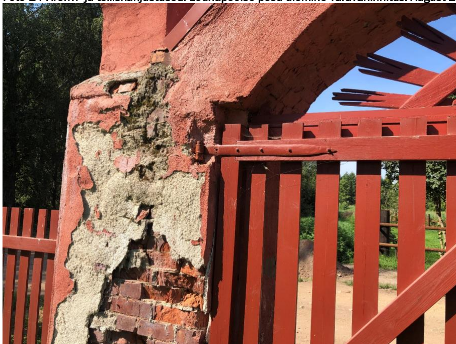
Foto 14 Krohvi- ja telliskahjustused. Lõunapoolse posti ülemine värvakinnitus. August 2022
