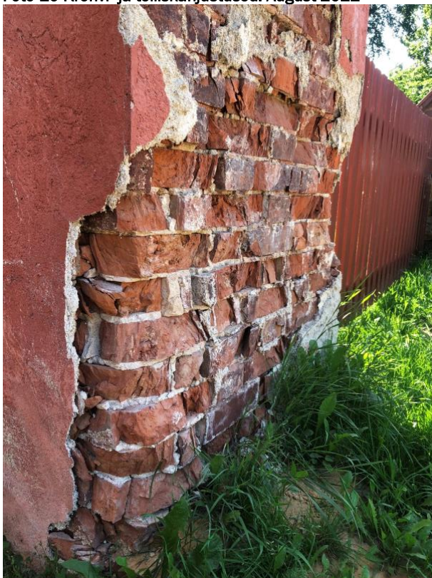
Foto 10 Krohvi- ja telliskahjustused. August 2022
