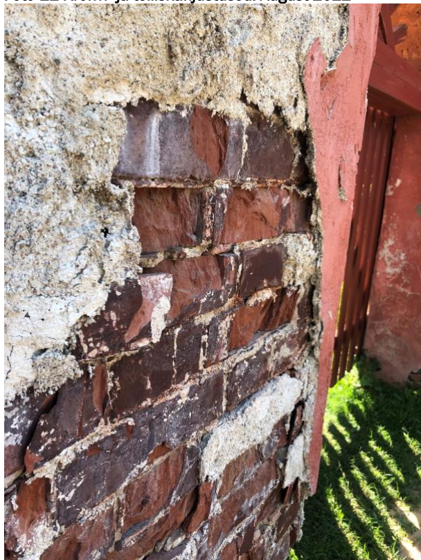
Foto 12 Krohvi- ja telliskahjustused. August 2022
