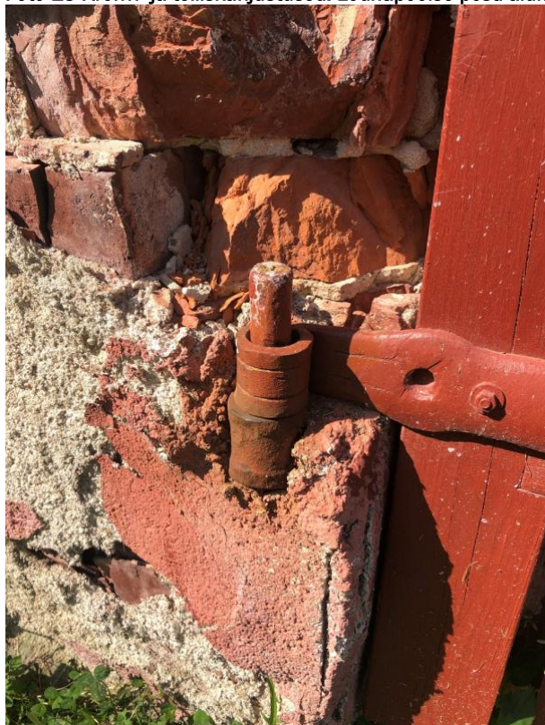
Foto 14 Krohvi- ja telliskahjustused. Lõunapoolse posti ülemine värvakinnitus. August 2022
