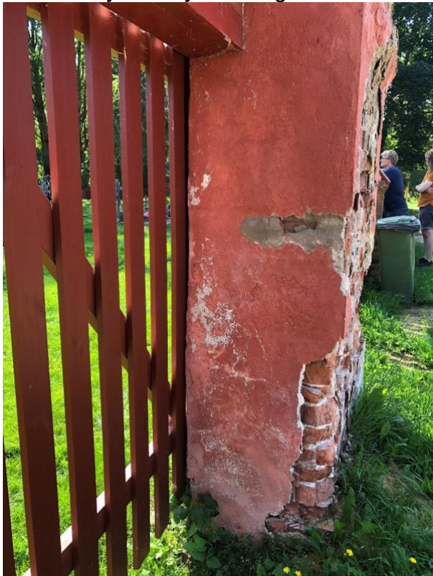
Foto 10 Krohvi- ja telliskahjustused. August 2022
