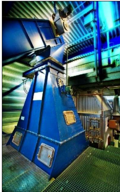
Joonis 2. Kütuse ladustamine (vasakul) ja söötursüsteem (paremal)
